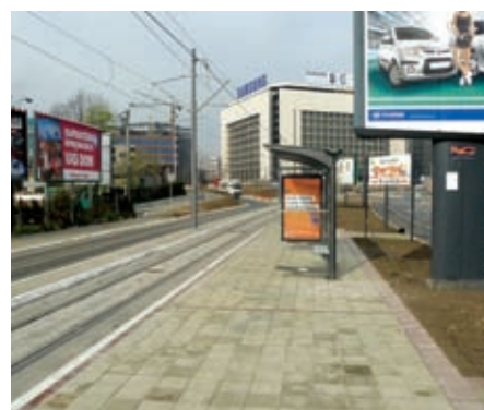
Slika 4. Sanacija tramvajske pruge i kontaktne mreže u ulici Zemunski put
