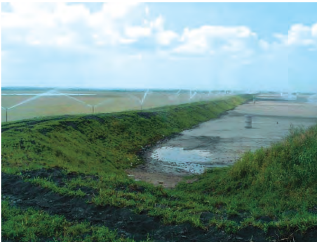
Sistem za kvašenje rekultivisanih i novoizgrađenih nasipa
